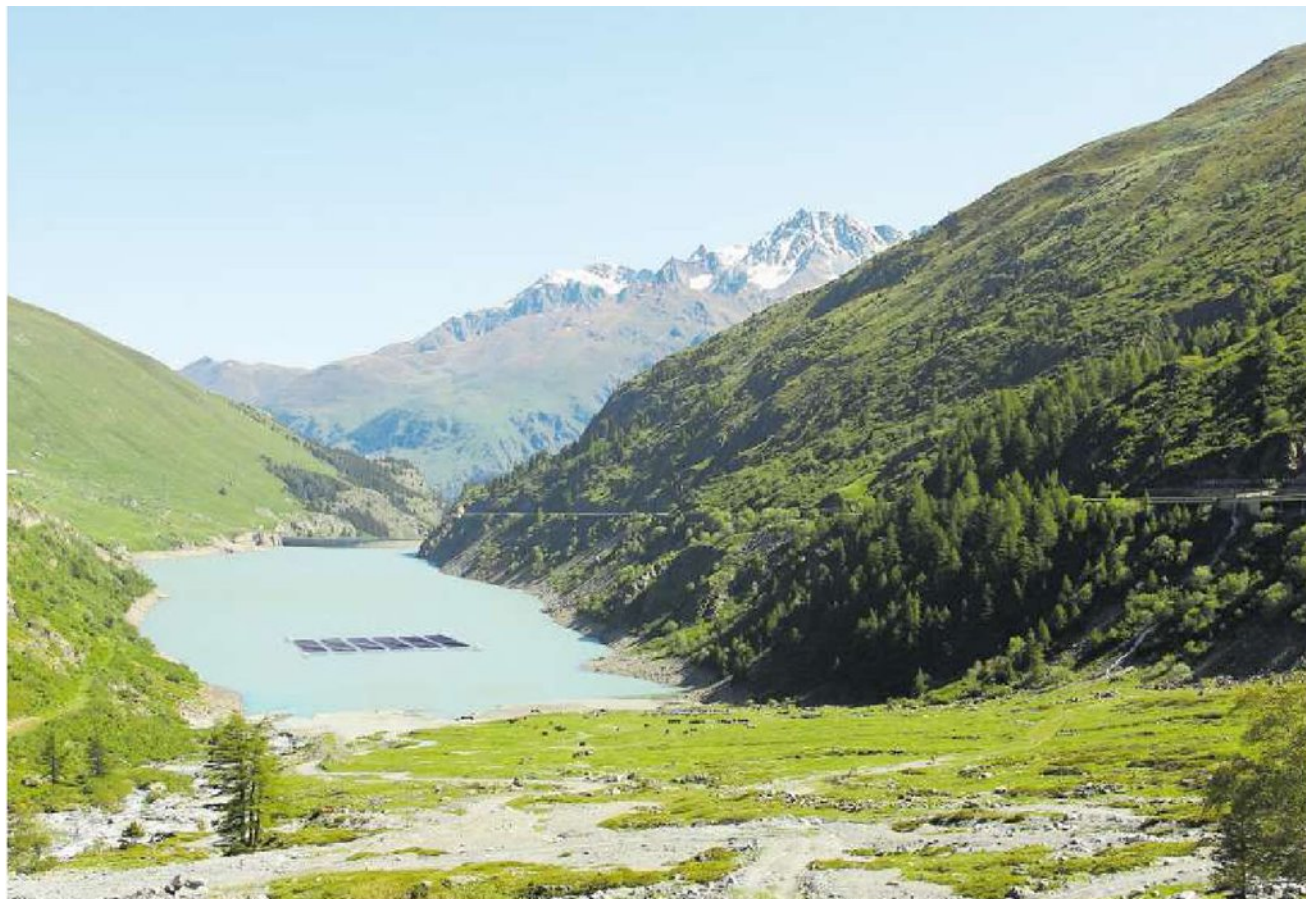
Die Pilotanlage auf dem Lac des Toules ist etwas grösser als ein Fussballfeld.
